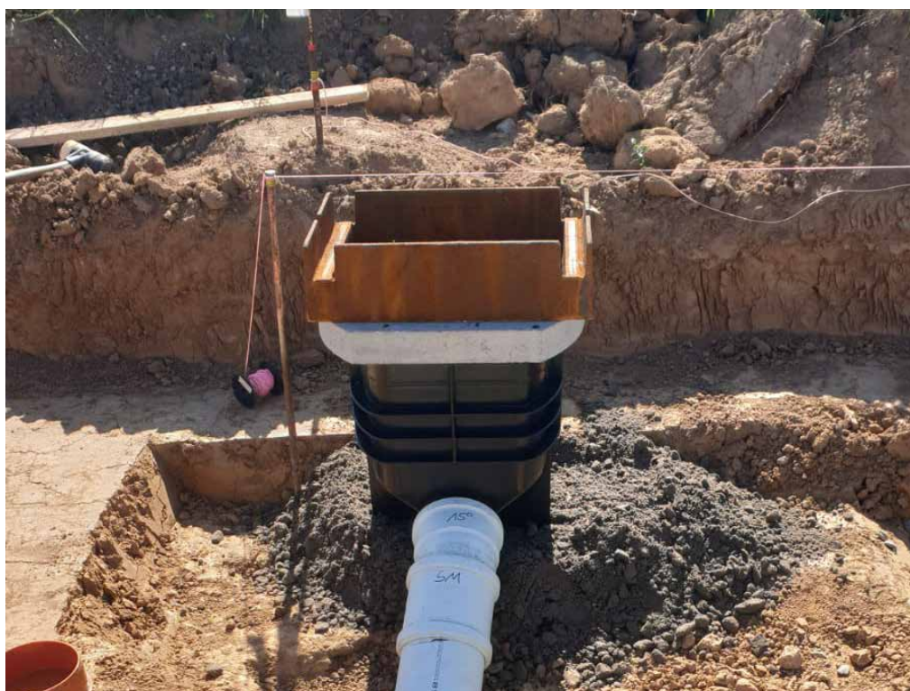
ADUXA STRASSENABLAUF MOD.35 MIT ANSCHLUSS AN EIN KANALROHR DN 150
