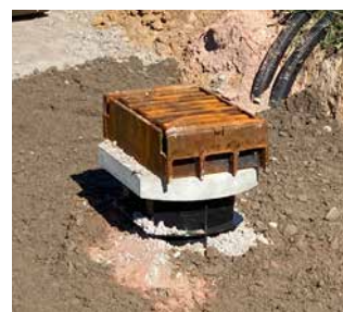
ADUXA STRASSENABLAUF MOD.35 MIT ANSCHLUSS AN EIN KANALROHR DN 150
